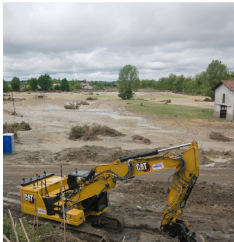
I lavori all'argine di Boncellino FOTO MASSIMO FIORENTINI
